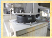
積層ゴム免震装置
